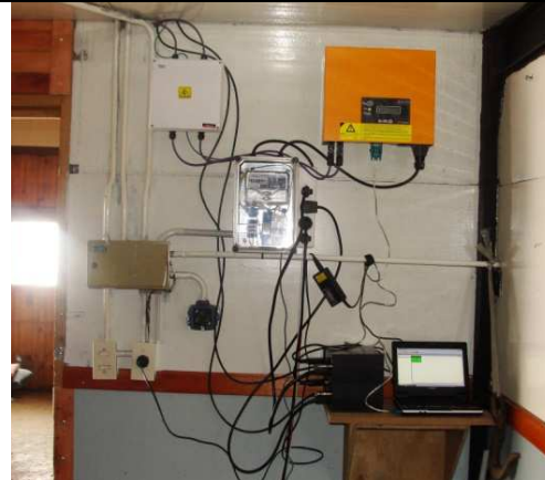
Fig. 27: Instalación interna y monitoreo del sistema FV de la Terminal de Pasajeros Fuente: Ing. Eduardo Martins Do Vale, 2016.
