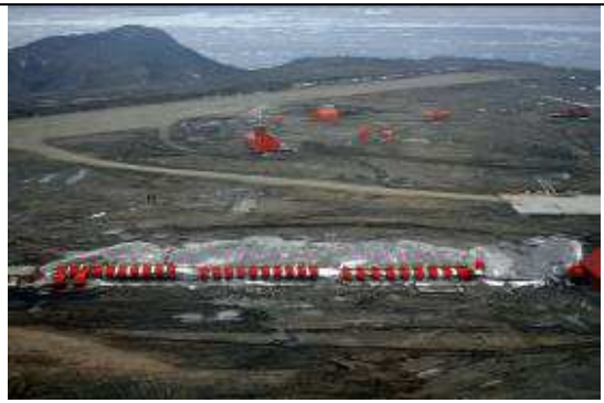
Fig. 15: Batería de cisternas de GOA para la usina de Marambio. Fuente: Autor, 2014.
