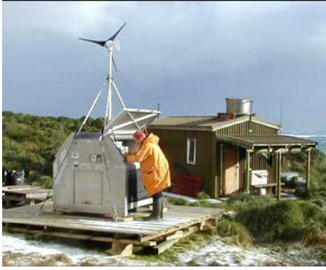
Fig. 24: Vista de un sistema RAPS instalado junto a un refugio subantártico. Fuente: AAD, 2009. http://www.antarctica.gov.au/
