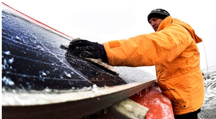
Fig. 28: Limpieza de paneles tras una nevada. Fuente: Télam, 2016.
