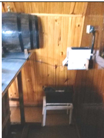
Fig. 34: Bateria para alimentación de luminaria. Fuente: Autor, 2018.
