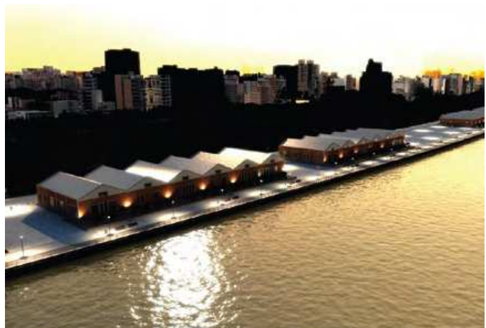
Imagen 67: Proyecto rehabilitación galpones
