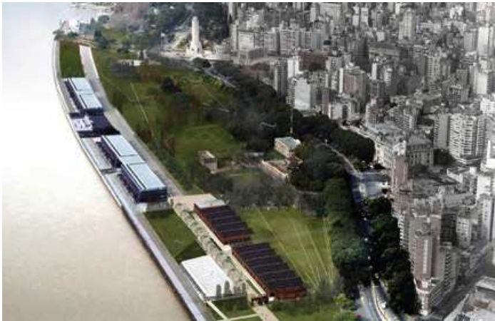
Imagen 66: Proyecto rehabilitación galpones
