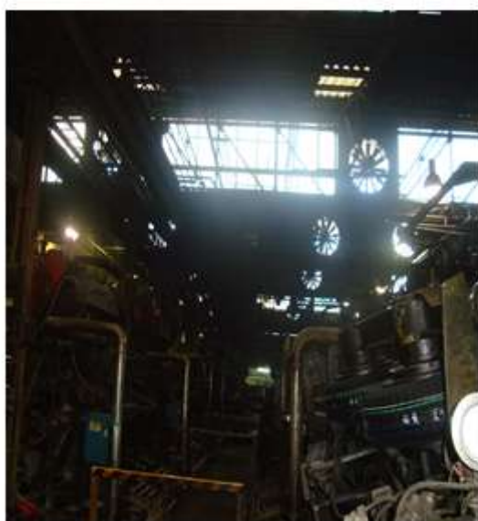
Actual sistema de extracción de aire de vulcanizado
