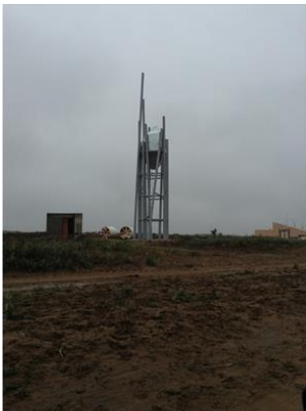
Figura 6. 3. Tanque de agua. Año 2014
