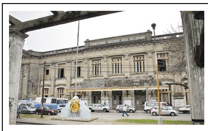
Figura 32 - Ex Estación Belgrano deteriorada.
