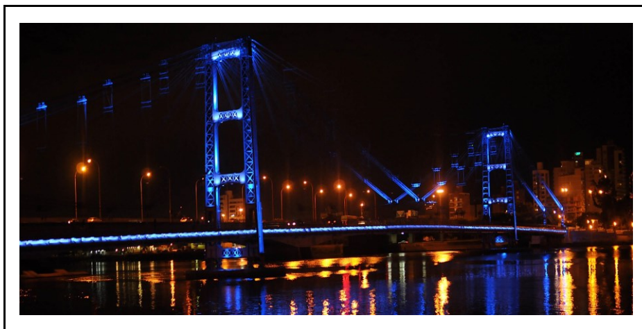
Figura 40 - Puente Colgante con iluminación LED.
