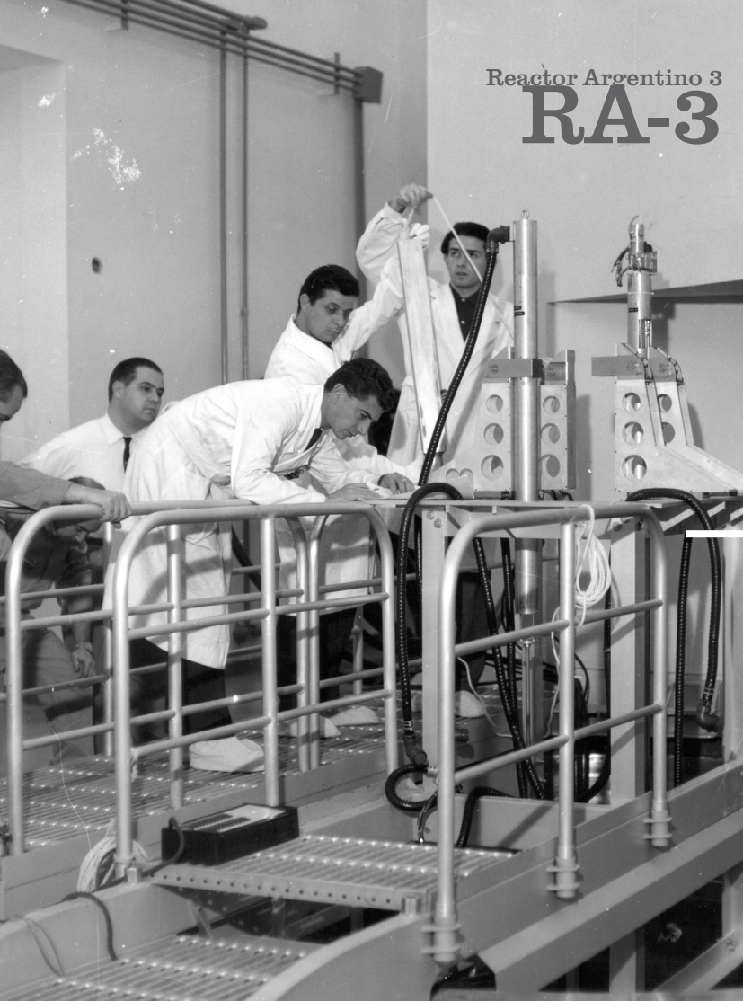
Izquierda: manipulación de las barras de control. Arriba: el núcleo del reactor en funcionamiento.
