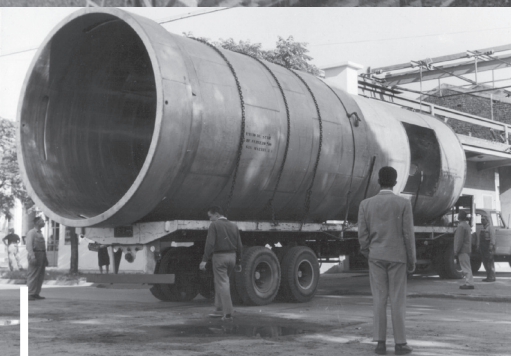
Traslado e instalación del tanque del reactor Fotografías: Archivo CNEA / Gentileza Rafael Castro
