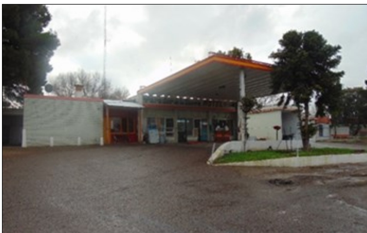
Figura Nro. 24: Estación de servicio contigua al área protegida (riesgo).
