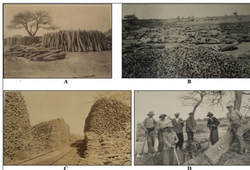
Figura Nro. 10: Galería de fotos históricas del circuito forestal (1930).
