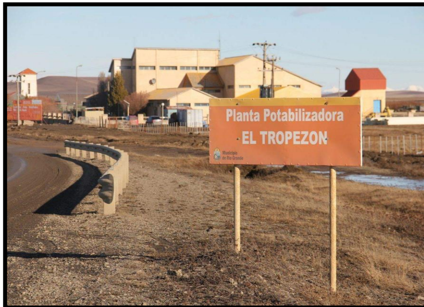
Imagen1: Planta Potabilizadora en la Margen Sur.
