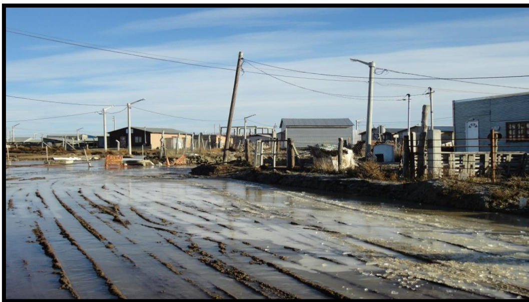
Imagen 10: Anegamiento y gran impermeabilidad de los suelos. Fuente: Paoloni 2018.
