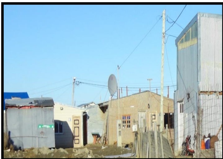
Imagen 6: Ejemplo de hacinamiento de viviendas y el peligro que ello confiere. Fuente: Paoloni ,2018.
