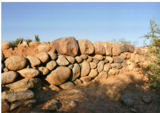
Muro Perimetral. Estado Actual (Fuente propia:2014)
