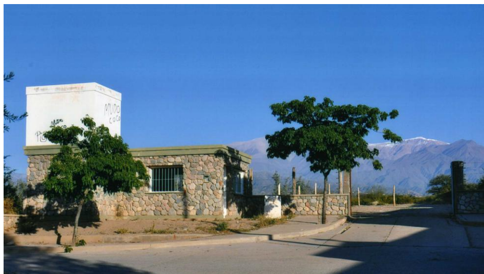
Vista del ingreso al Sitio arqueológico. Fuente propia, 2014.
