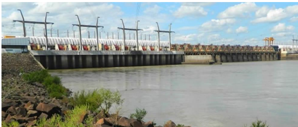
Imagen N°8: Complejo Hidroeléctrico Salto Grande.
