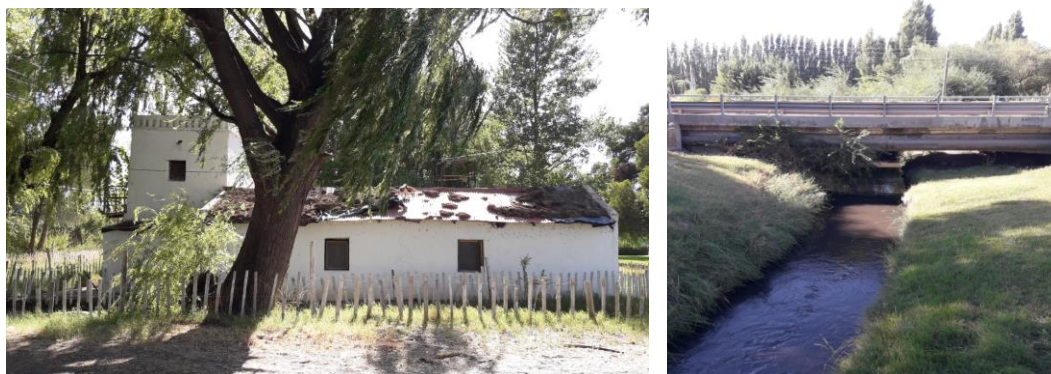
Figura 5: (Izq.): Fortín primera división de la ciudad de Cipolletti. (Der.): actual canal de los milicos en la zona del puente carretero.
