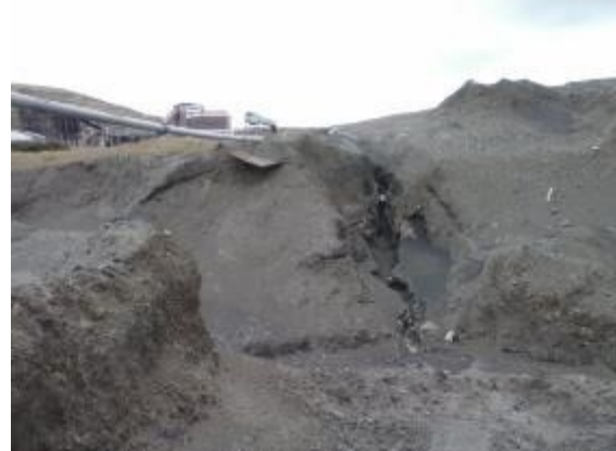
Fig. 18 Formación de cárcavas por rotura de caño de lodos. El lodo se desvía directamente al canal.
