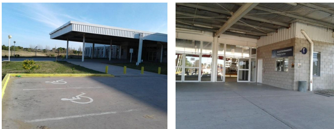
Figura 11. Nueva Terminal de Ómnibus de Villa Gesell
