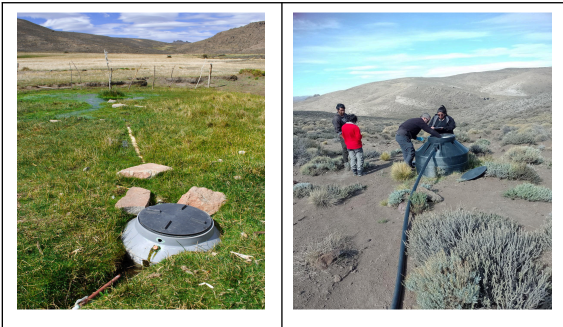
Fig. 32 (izq): Lugar de la toma y tanque de la muestra A6, con un cerco abierto. Fig.33 (der): Tanque del que se distribuye el agua a cuatro viviendas (A8).
