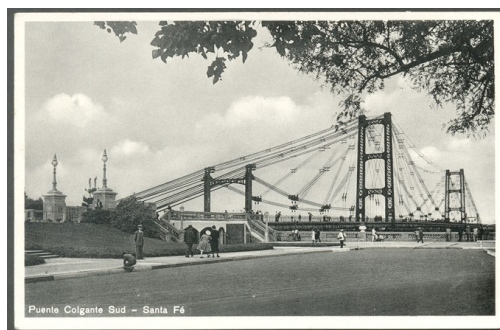
Imagen 4: El Puente Colgante Ingeniero Rafael Marcial Candiotti, en los '70
