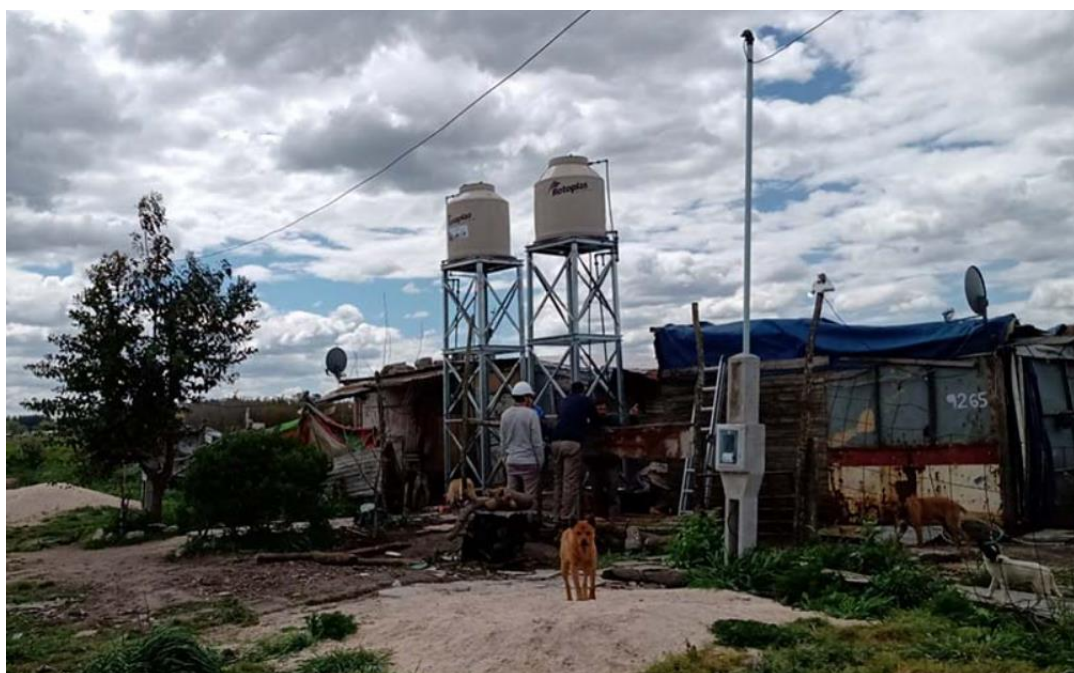
Fotografía N°2: Instalación de torres para tanques de agua en el Barrio El Caribe
