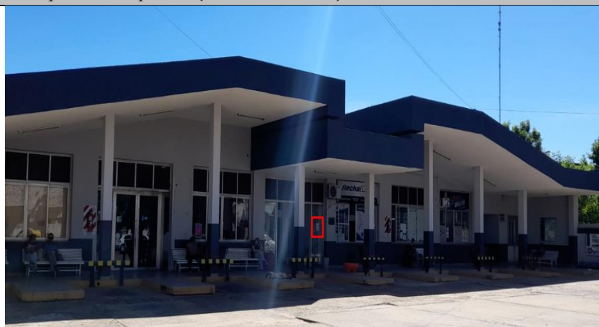
Terminal de Ómnibus San José (Barrio Centro)
