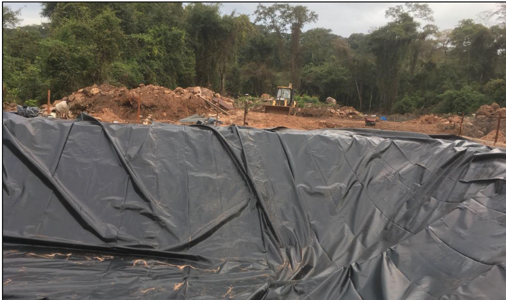
Foto 12: Colocación de membrana HDPE
