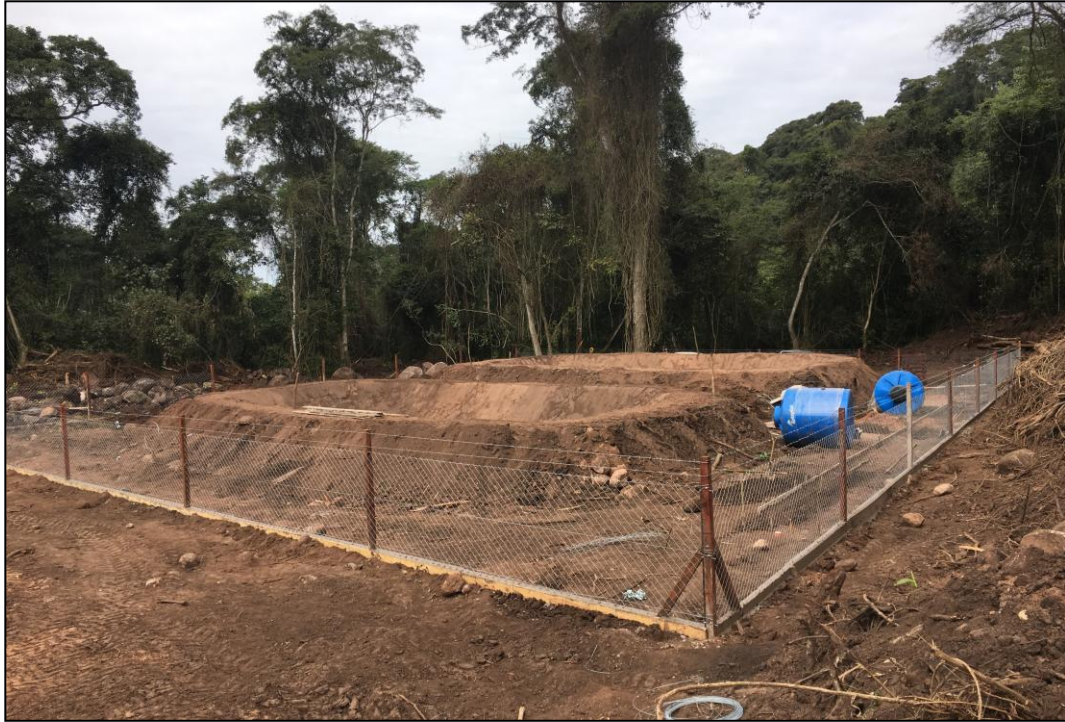
Foto 16: Piletas y cerco perimetral
