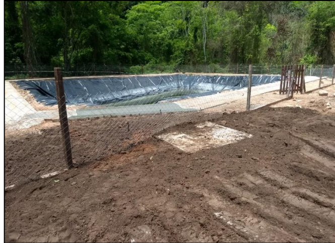
Foto 24: Reparaciones en inmediaciones de represa
