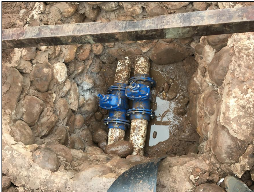
Foto 19: Válvulas guillotina
