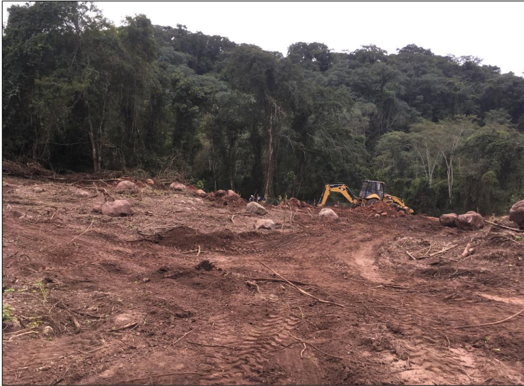
Foto 8: Apertura de la planchada de la represa
