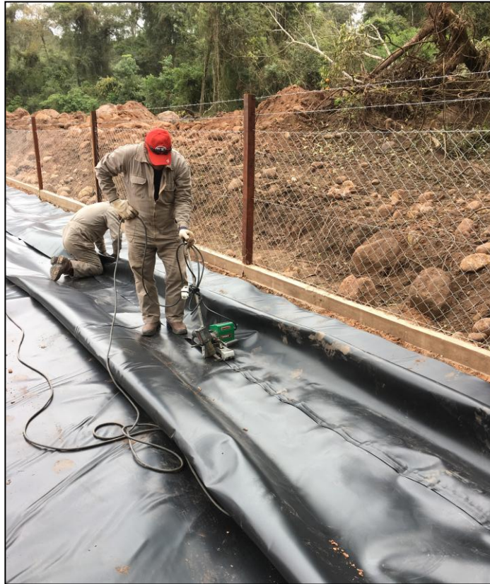
Foto 13: Colocación de membrana HDPE
