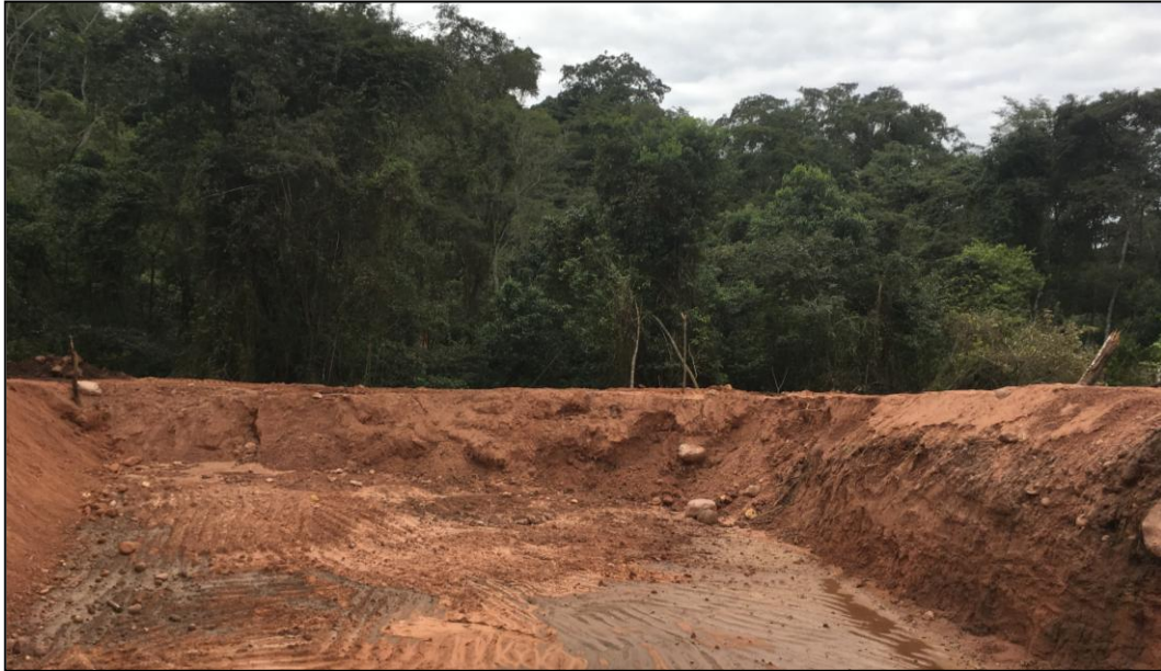
Foto 11: Etapa inicial de la construcción de la represa
