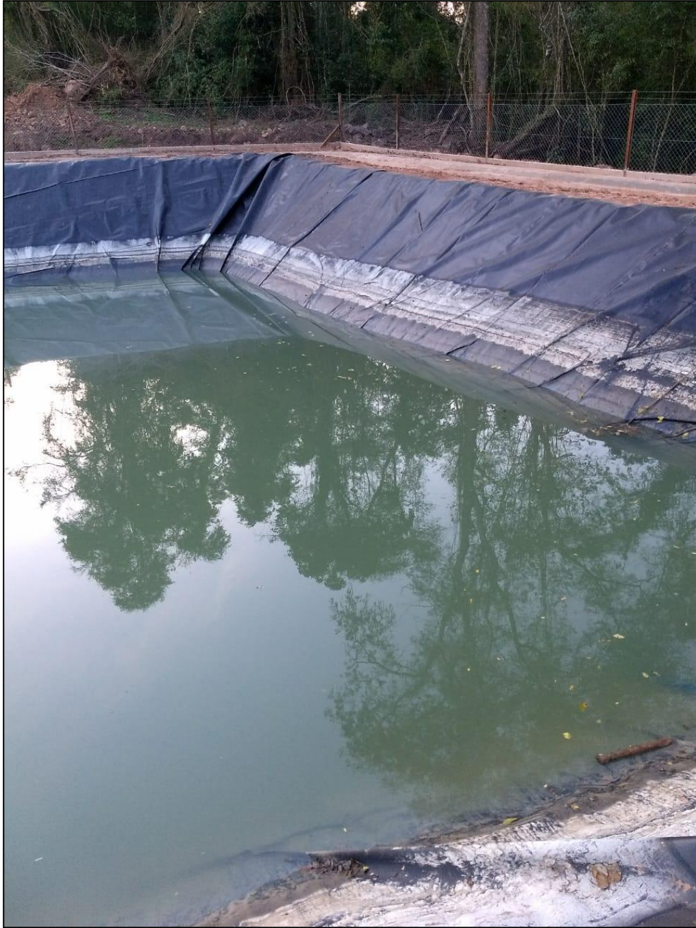
Foto 21: Represa en funcionamiento
