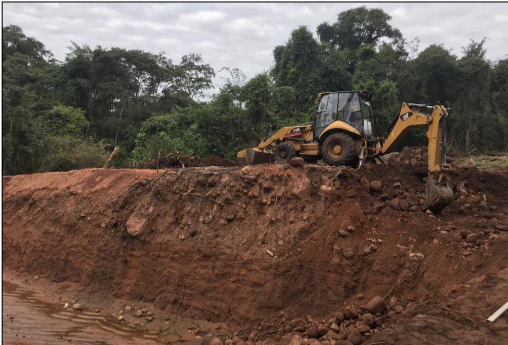
Foto 10: Etapa inicial de la construcción de la represa
