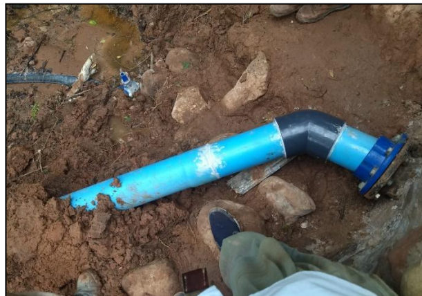
Foto 23: Reemplazo codos
