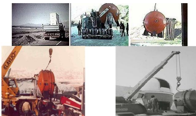
Ilustración 13. Vista de la grúa de transporte de la campana de alto vacío y el transporte (Fotos de Willemöes)
