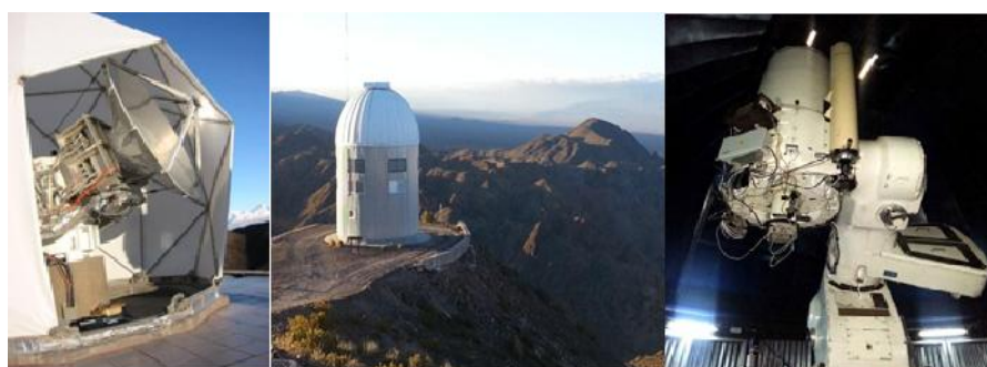
Ilustración 22. De Izq. a Der.: Telescopio SST. Edificio que alberga al telescopio HSH en el Cerro Burek. Telescopio Helen Sawyer Hogg (HSH). Fuente: https://CASLEO.CONICET.gov.ar/historia-sitio/
