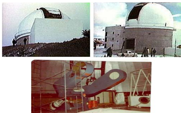
Ilustración 14. Arriba: Detalle de la cúpula vista exterior. Abajo: La horquilla instalada dentro de la cúpula
