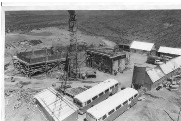
Ilustración 5. Primeras obras de construcción de la base del telescopio (Fotografía del autor)
