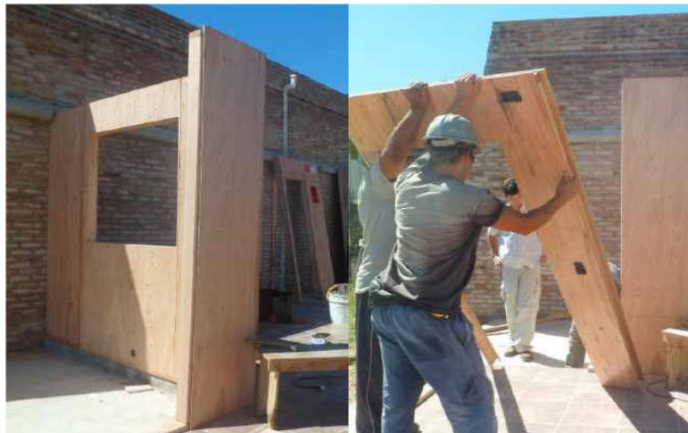
Imagen 17. Sistema de machihembrado lateral entre paneles y encastre inferior a la solera, en momento de obra
