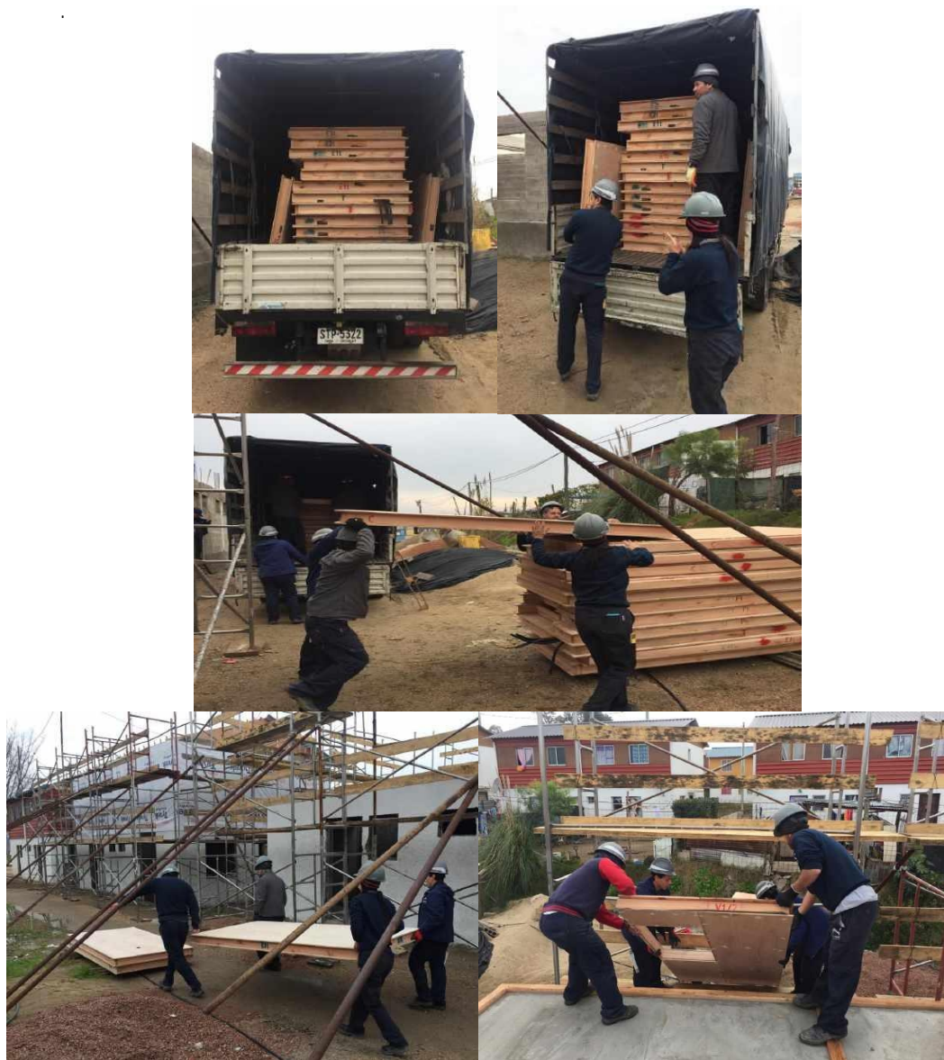
Imagen 14. Descarga y transporte manual para su montaje en obra
