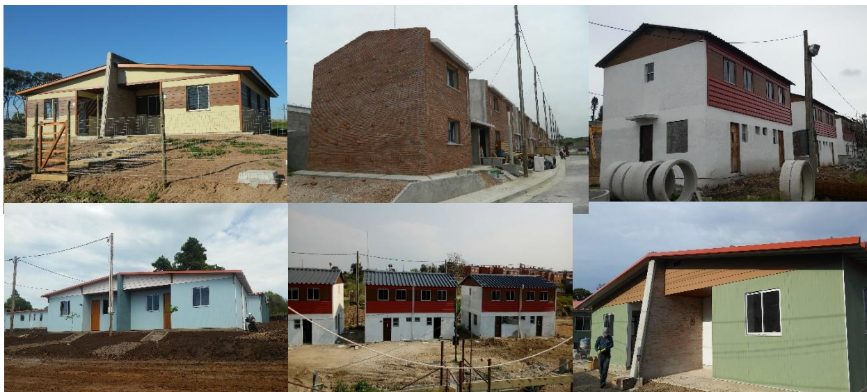
Imagen 3. Viviendas finalizadas en el marco proyectos realizados junto a organismos del Estado
