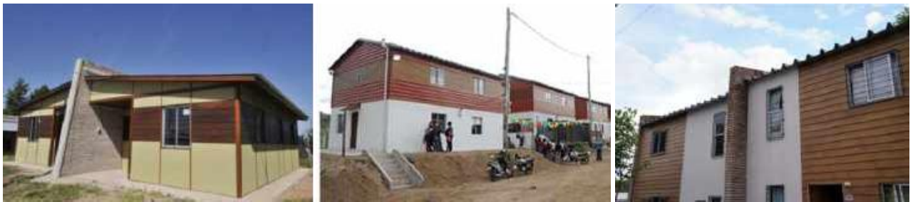
Imagen 6. Viviendas apareadas de un nivel en planta baja y en un nivel en tira en planta alta sobre planta baja en sistema tradicional
