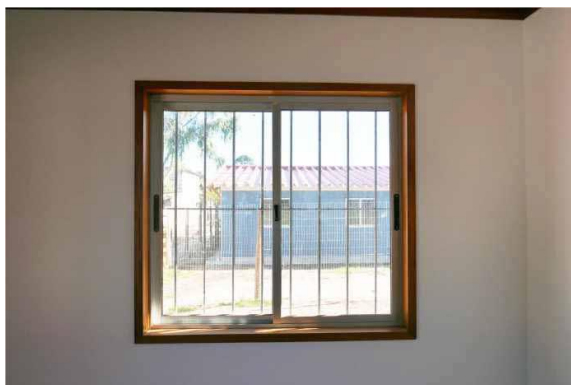
Imagen 9. Ventana colocada y finalizada interiormente con una chambrana o forro de mocheta de madera en forma de L de 36,5 x 75mm de espesor, pintados con protector para madera y se colocan mediante clavos sin cabeza
