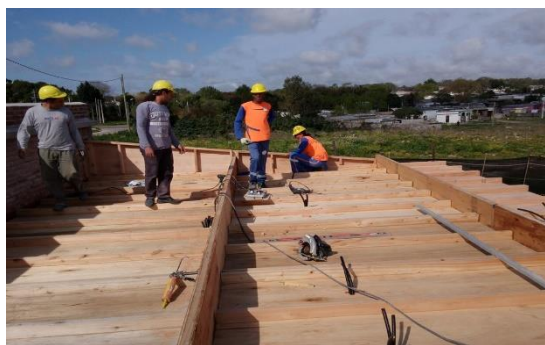
Imagen 15. Trabajadores en etapa de montaje en obra
