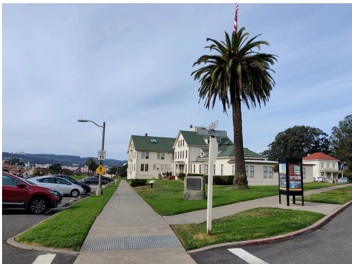
Figura 1.6: Intersección principal dentro de Fort Mason, calles MacArthur y Pope. El histórico edificio de tejas verdes (N°201) es la actual Oficina Central (Headquarters) de GGNRA. A la derecha, el histórico edificio N°204, también utilizado como oficina de GGNRA. Se observan elementos paisajísticos históricos, como el cuidado césped alrededor de estos edificios, así como también elementos modernos, como lo son la rampa en el cordón de la vereda, las señales de tránsito y la cartelería de interpretación. Fuente: propia, abril 2022.
