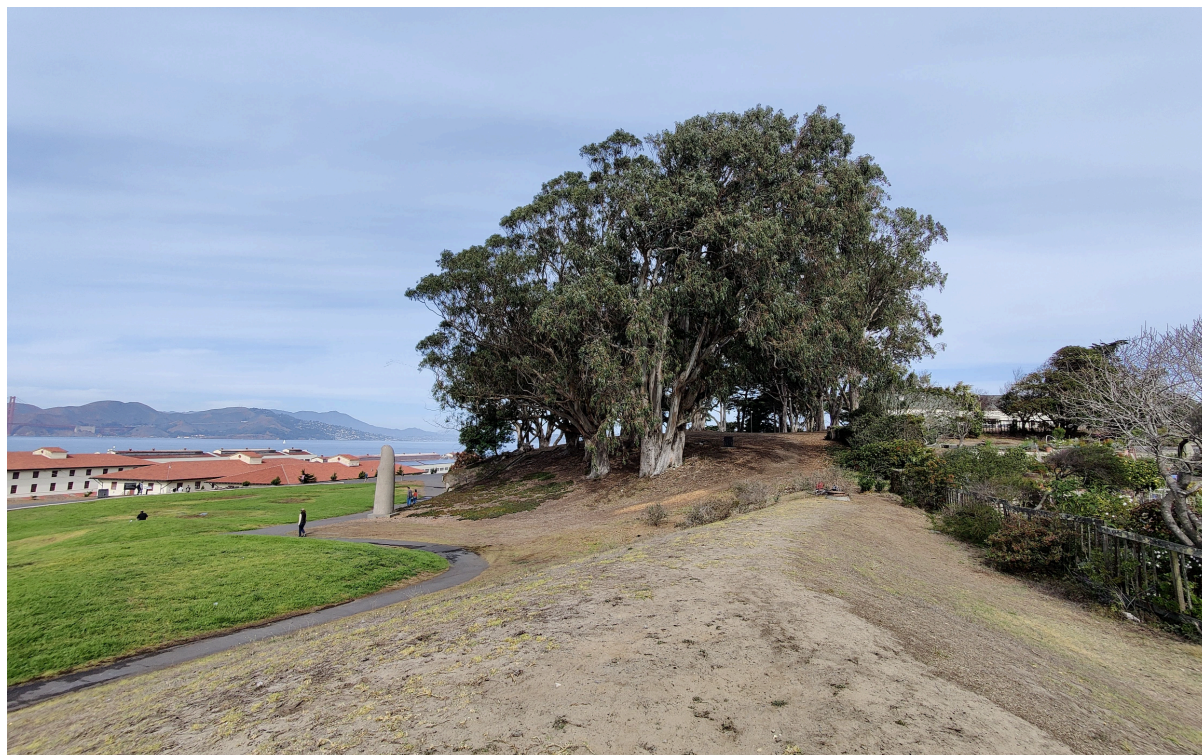
Figura 3.11: Terraplén sin irrigar, vista hacia el norte. Nótese el suelo arenoso expuesto. Octubre de 2022.
