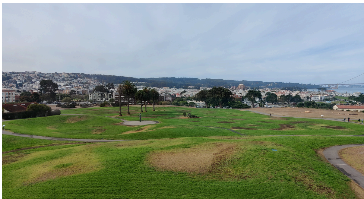
Figura 3.10: Great Meadow, vista hacia el oeste. Las manchas marrones en el césped denotan la ubicación de los aspersores, cuyo correcto funcionamiento se ve afectado por inadecuada presión. Octubre de 2022. Fuente: propia.
