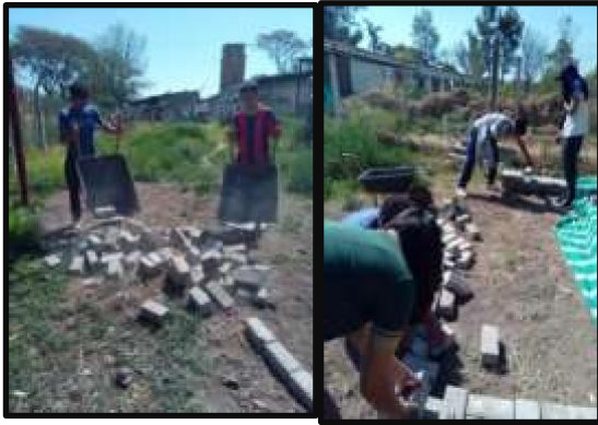
Figura 1. Elaboración de composteras con hormigón. Elaboración propia
