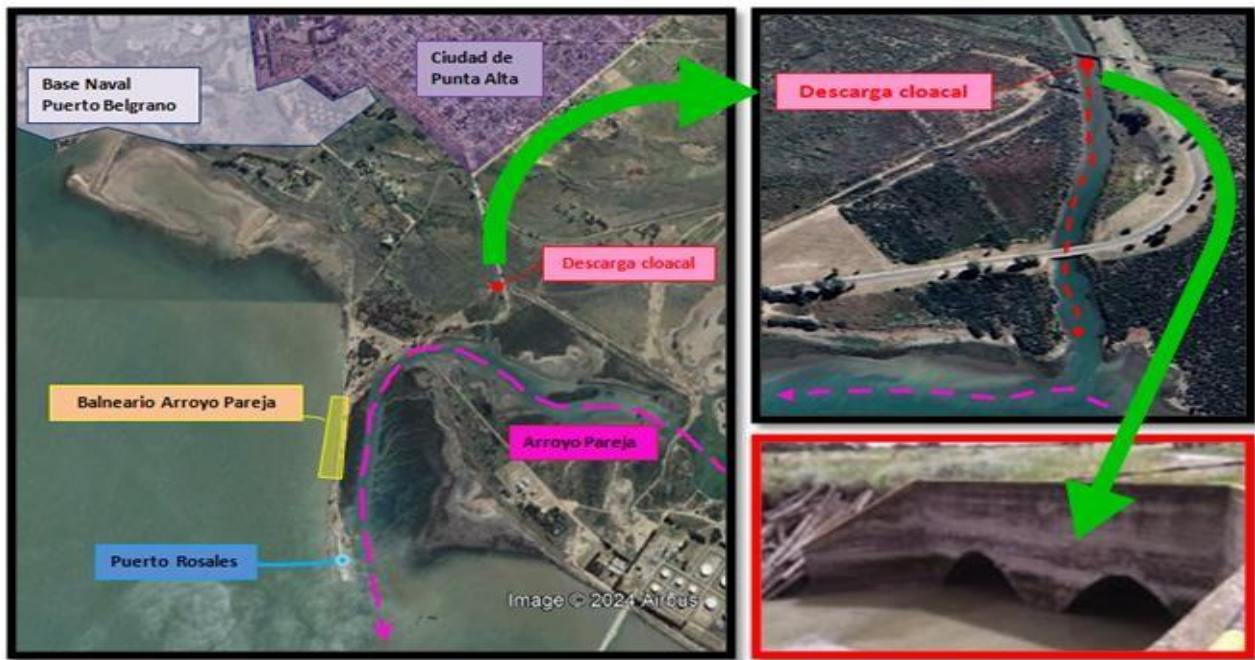
Foto 3: Zona descarga cloacal de la ciudad de Punta Alta. Fuente: propia.
