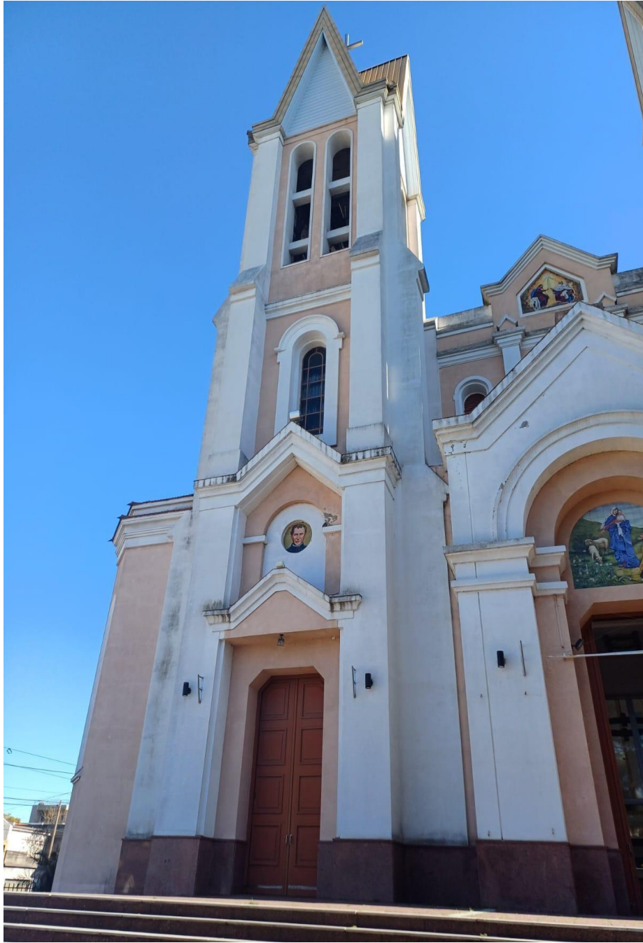
Figura N°33: Pared externa y puerta
