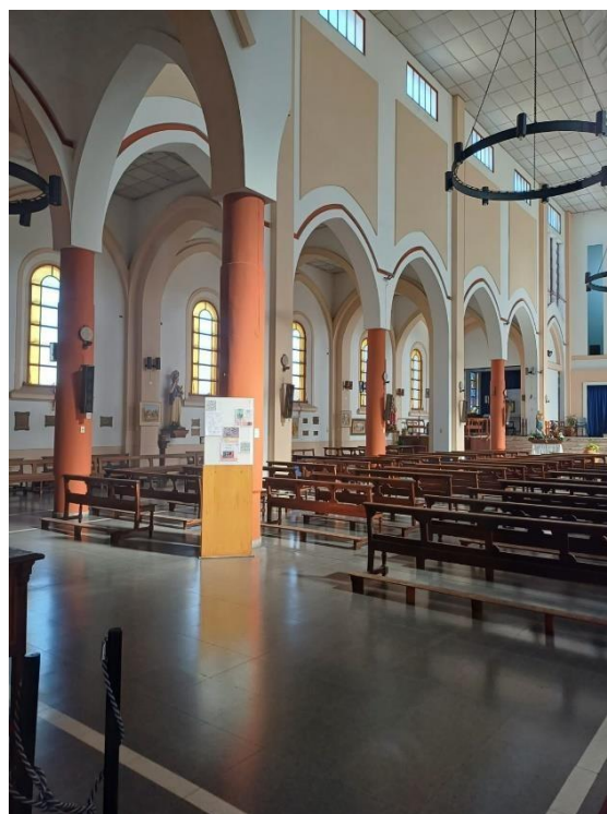
Figura N°24: Vista completa del interior con altar
