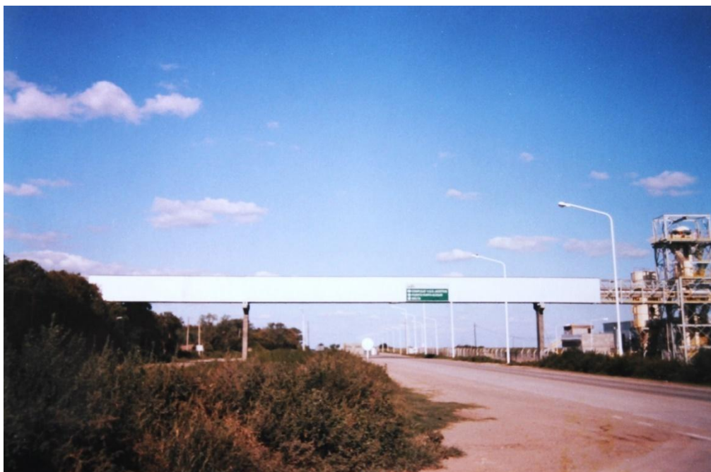
Figura 64. Puente aéreo Fuente: fotografía tomada tras la construcción del puente, proporcionada por una vecina del barrio Santa Inés, s/d.
