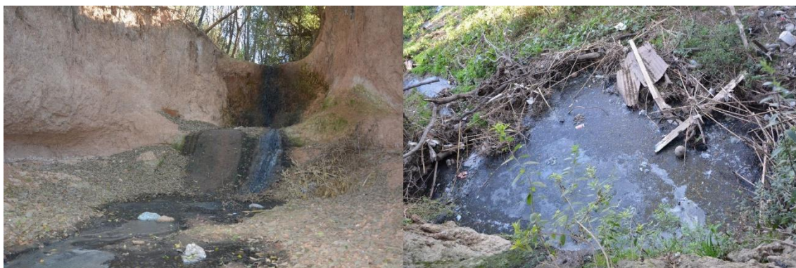
Figura 68. Desagüe pluvial, Ibai Ondo Captura propia, 19 de junio de 2024
