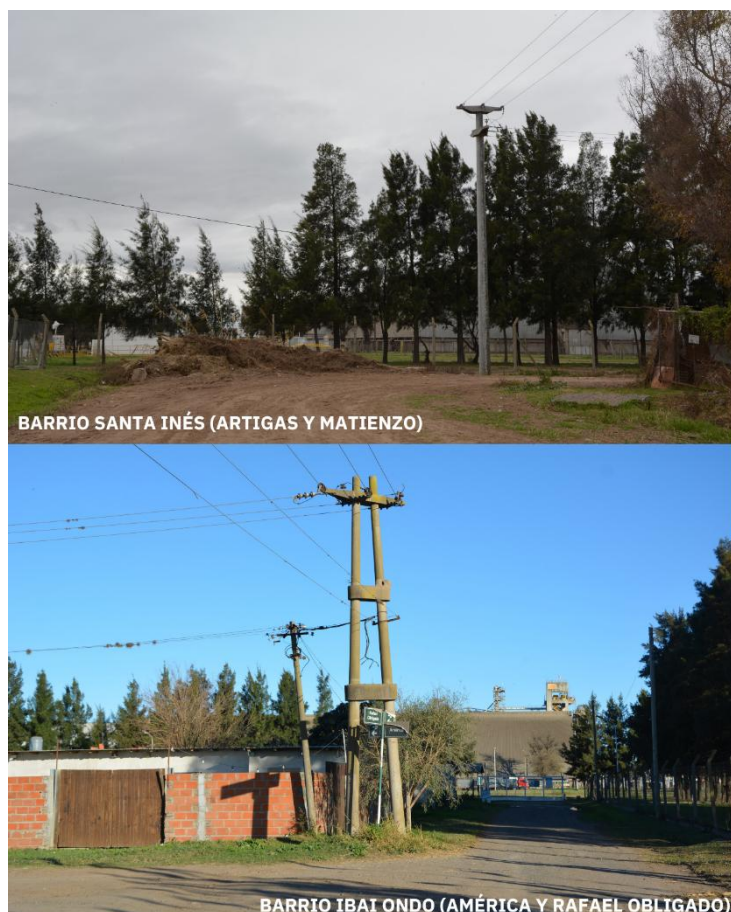
Figura 57. Obstrucción del espacio público en los barrios Ibai Ondo y Santa Inés Capturas propias, agosto 2024
