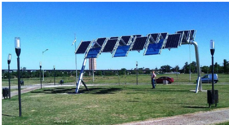
Figura 45: Primera instalación de GDER, proyecto IRESUD
