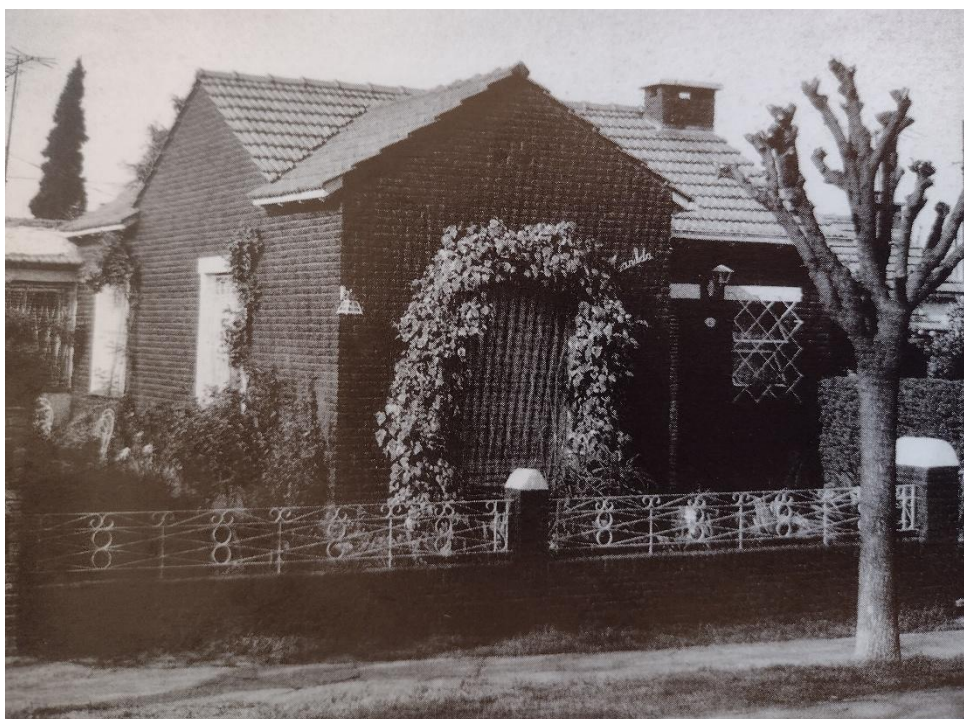
Imagen 11: chalet “estilo californiano” edificado por EHO en el “Barrio Modelo Villa Lugano”. Fuente: Dunowicz y Villaveirán (2013).
