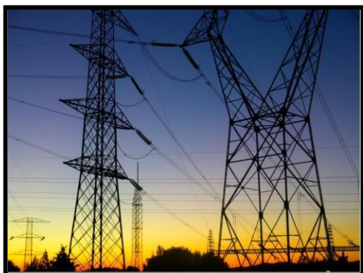
Fotografía N° 1 Cables Aéreos Subterráneos
