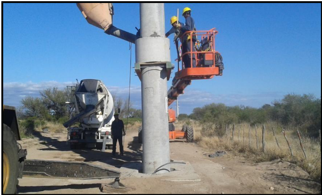
Fotografía N° 10 "Armado de Estructuras Doble"
