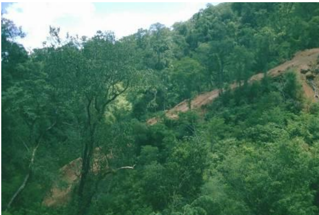
Imagen1: Desmonte de ladera para gasoducto con pendiente, en Yungas (Fotos Fundación CEBIO).
