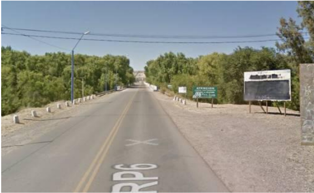
Foto I. Puente Paso Córdova
